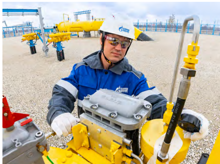
Слесарь по ремонту технологических установок Юрий Сурков переустанавливает положение шарового крана
