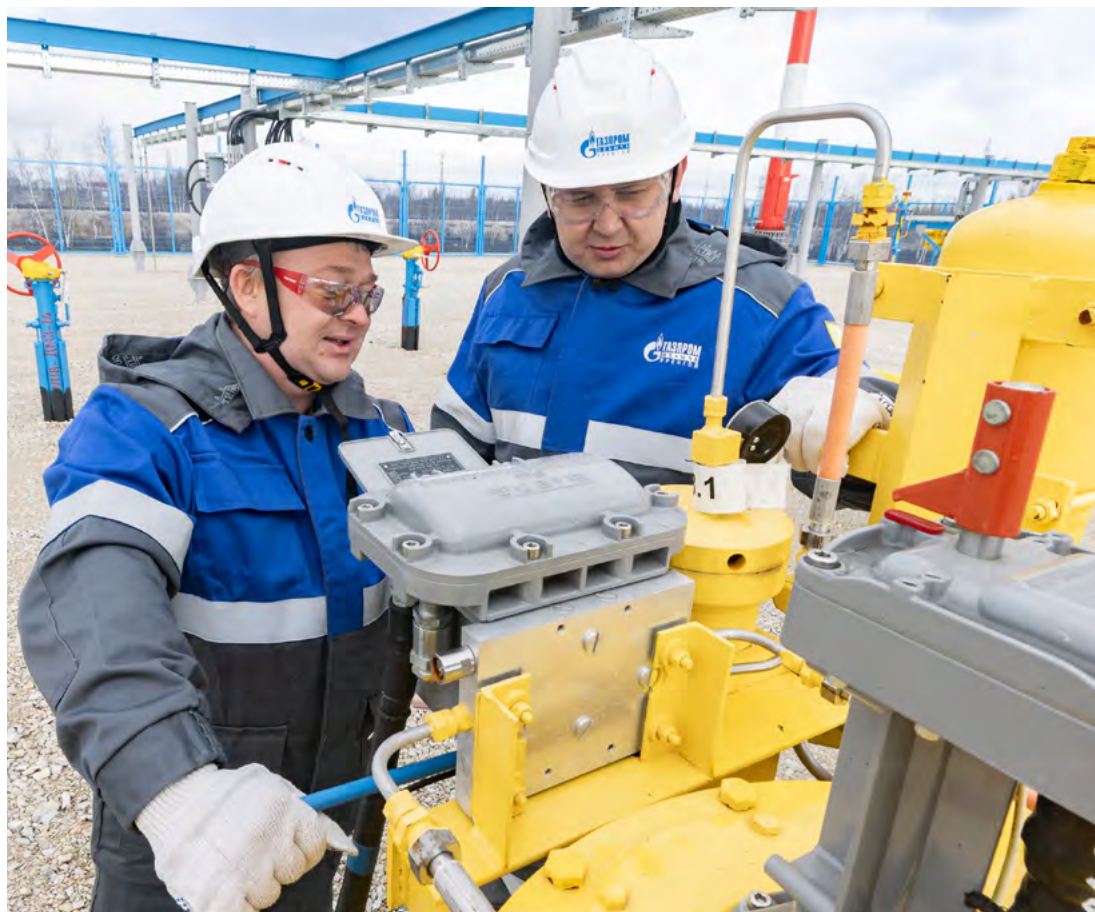
Слесари по ремонту технологических установок Сергей Теребейчик и Леонид Серегин осматривают привод шарового крана
