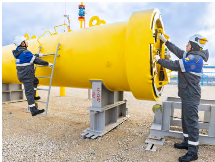
Слесари по ремонту технологических установок Денис Федоров и Владимир Крятов осуществляют наружный осмотр камеры запуска очистного устройства
