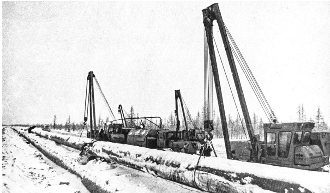
Начало освоения Уренгойского месторождения. Трубоукладчики опускают в траншею первые метры межпромысловых трубопроводов
