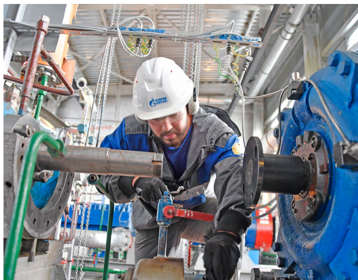
Слесарь по ремонту технологических установок Кирилл Поляков занят ремонтом насоса перекачки нестабильного газового конденсата
