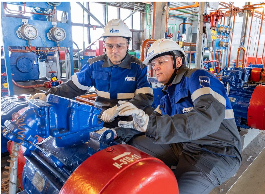
Электромонтеры по ремонту и обслуживанию электрооборудования газоконденсатного промысла № 1А Уренгойского газопромыслового управления Рустем Шакиров и Александр Карташов занимаются ремонтом и герметизацией клеммной коробки выводов электродвигателя насоса. **Фото Владимира БОЙКО**
